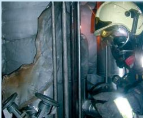
Die Betriebsfeuerwehr konnte den starken Gasaustritt stoppen.
